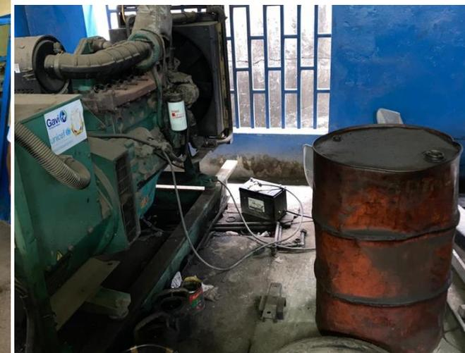
Fût de carburant à proximité du garage mécanique et baril de carburant près de la batterie de démarrage manuel du second générateur.
