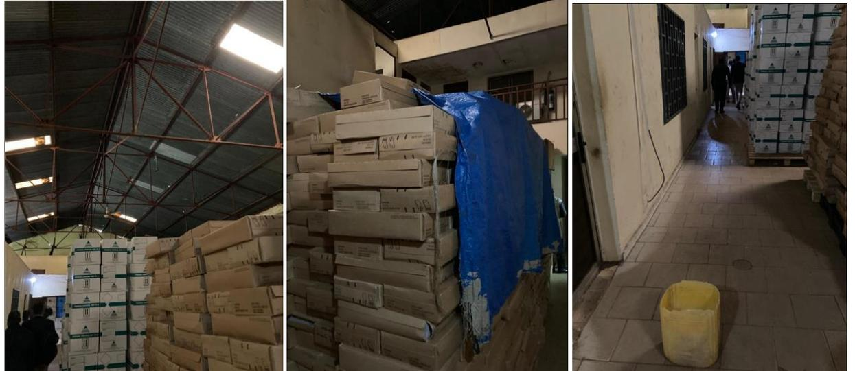
Cartons de seringues et autres intrants secs stockés sous un toit non étanche (mesure de protection de fortune contre l'infiltration d'eau dans le toit : bâche de couverture et bocal de recueil d'eau)
