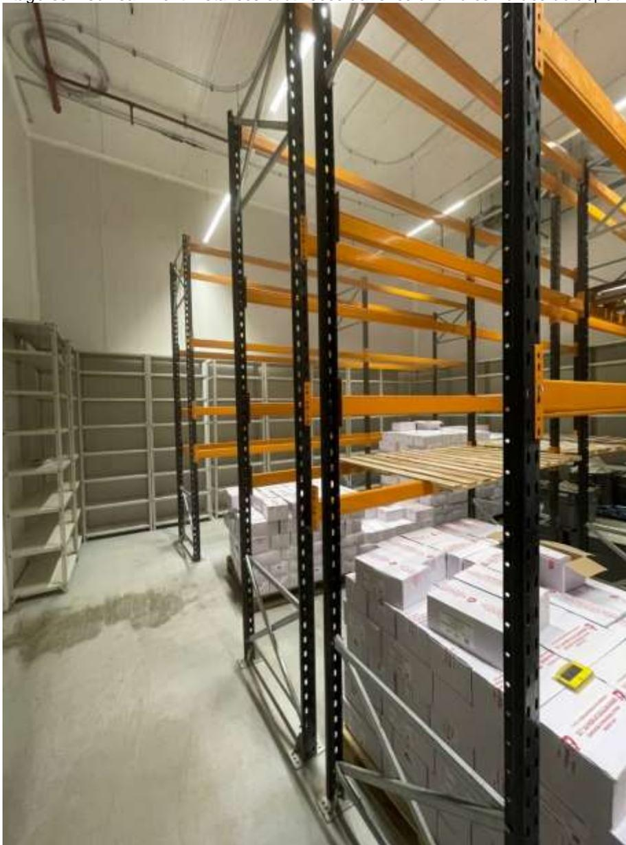
Rangement précaire bloquant l'accès à une chambre froide du dépôt central, cartons endommagés par les écoulements de condensation
